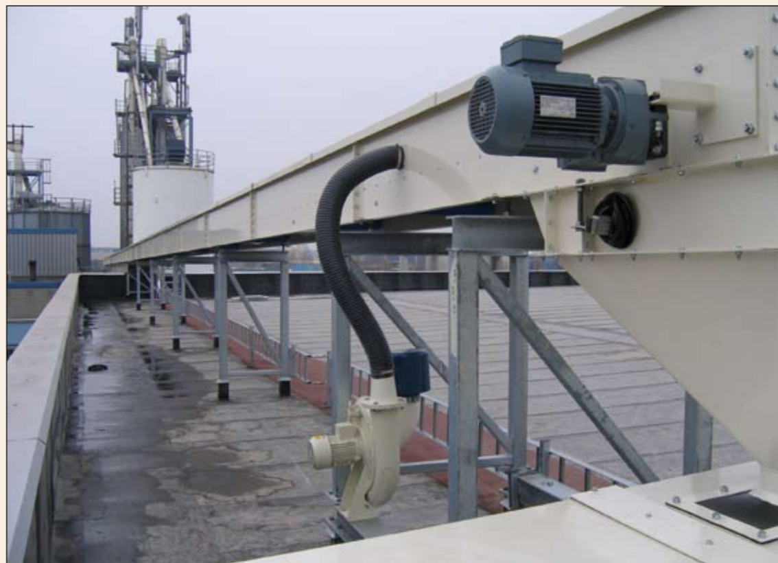
Figuur 2: Uitgevoerde luchtbandtransporteur (Airconveyors International BV) in geheel gesloten uitvoering, voor het transport van ca 40 m 3 /h houtpellets.
